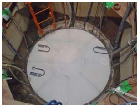
地下施設で実証中の地中無線装置
