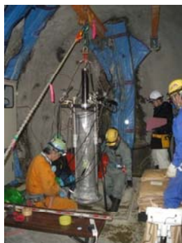
溶接部腐食試験装置の設置作業
