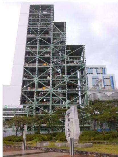
固体吸収材用パイロット試験装置(韓国)
