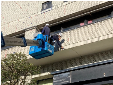
図5 外壁打診調査
