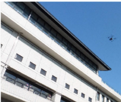
図6 NEDO機による熱画像の撮影
