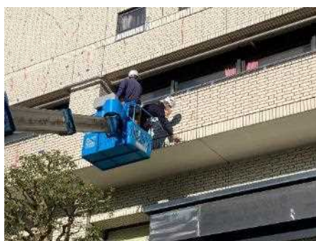
外壁打診調査
