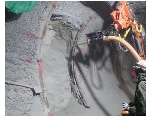
止水プラグの切欠き部に対する吹付けによる施工試験 (左) と、施工部の含水比・乾燥密度の関係
