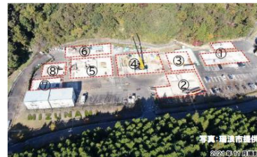
埋め戻し後の状況
