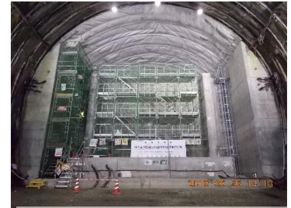
六ヶ所村の地下空洞での光ファイバー式センサーの実証試験
