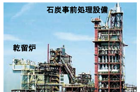
パイロットプラント外観
