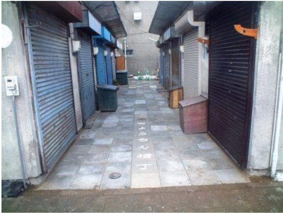
図 2 1 ポーラスコンクリートおよび施工状況
