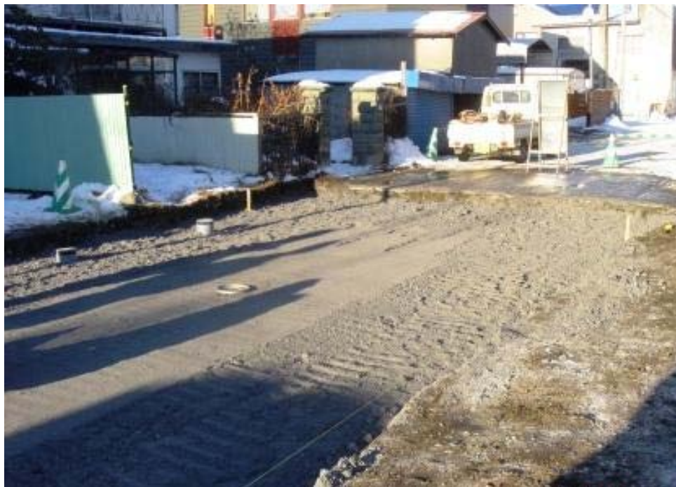
図19 市道施工テスト
