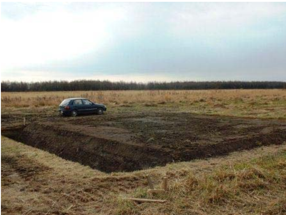
図 1 8 トリトウシ圃場施工
