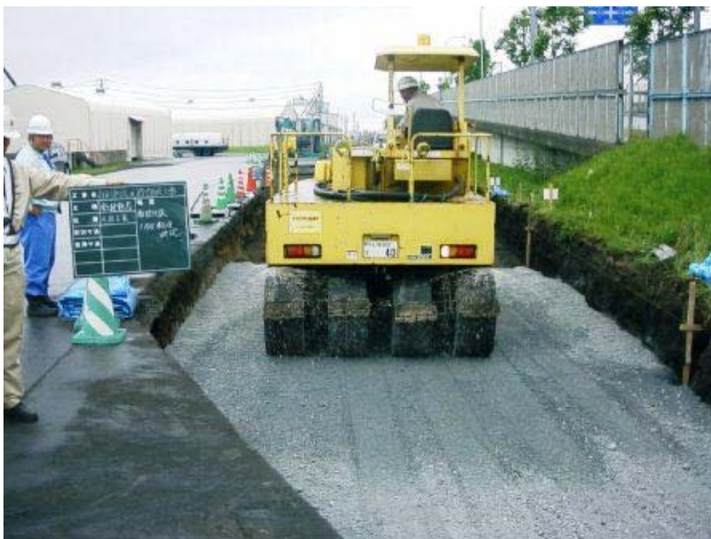
図 1 6 場内施工箇所
