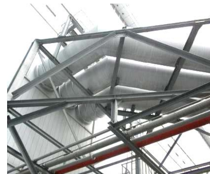
現状の発電機引出線(相分離母線)外観
