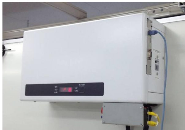
図 3-22. PCS の設置状況
