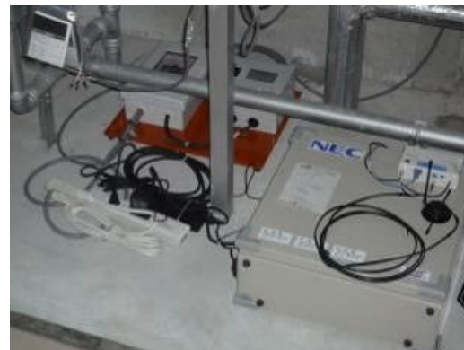
電気設備室への設置事例
