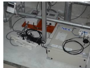
図 3-51. 電気設備室への 設置事例
