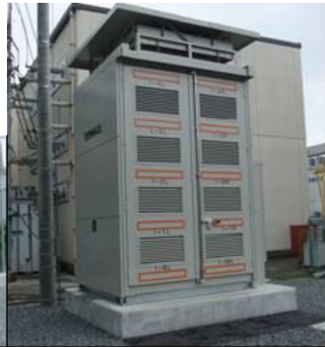
200kW NAS 電池
