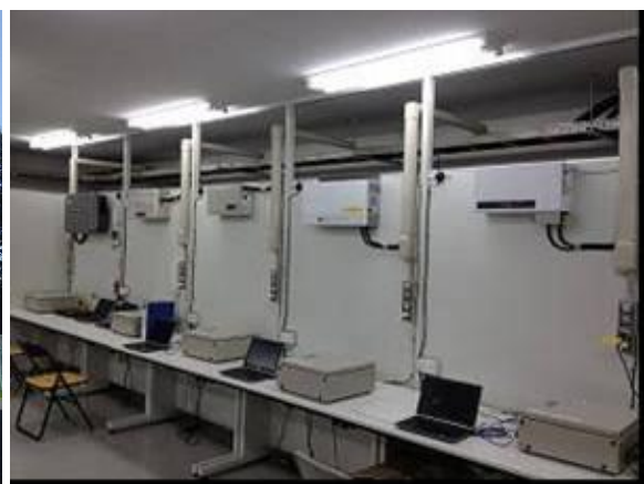
家庭用 PCS 設置状況
