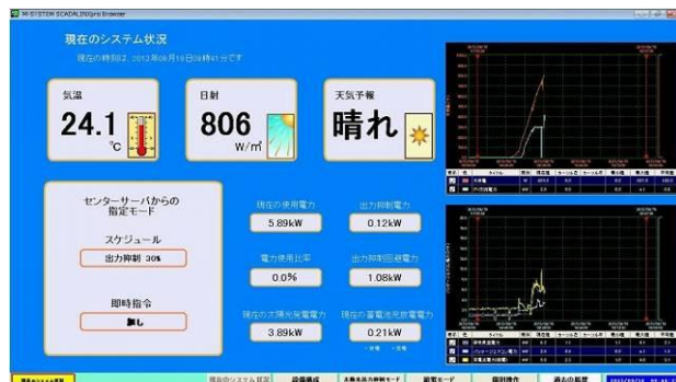
中央監視システム
