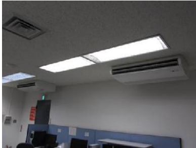
負荷設備 (照明、パッケージエアコン)
