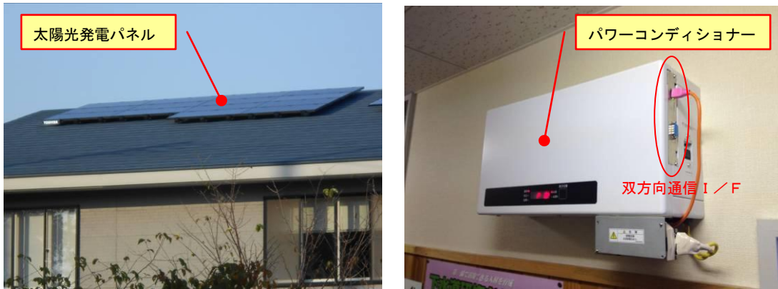
図 3-3. PV および PCS 外観
