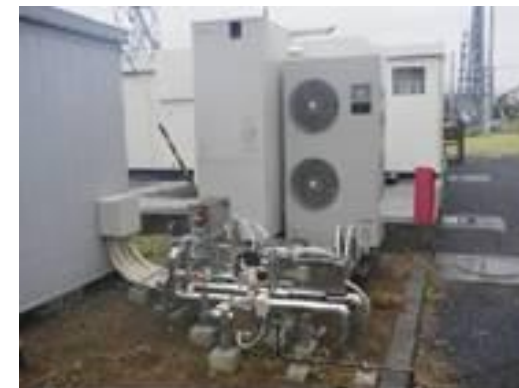
蓄熱設備(給湯用HP)
