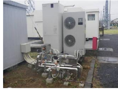
蓄熱設備 (給湯用 HP)
