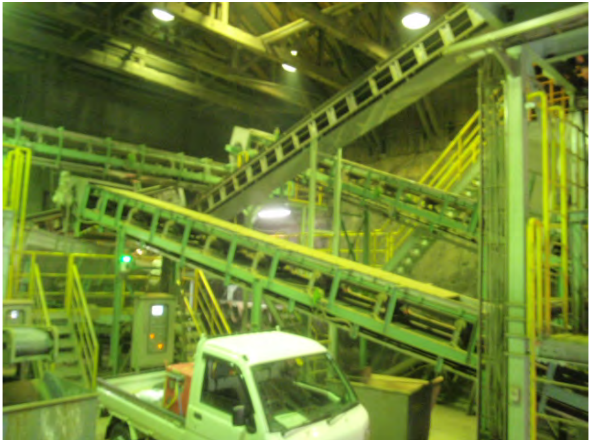
写真 3-3 造粒設備写真
