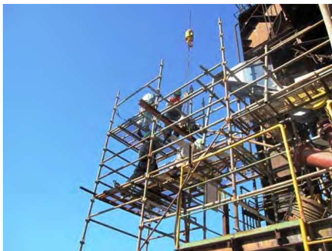
写真 3-7 焙焼炉設置時の乾式給鉱設備
