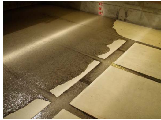
上部充填材充填状況
