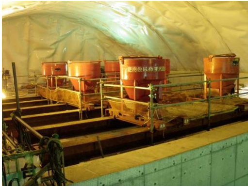
バケット設置状況
