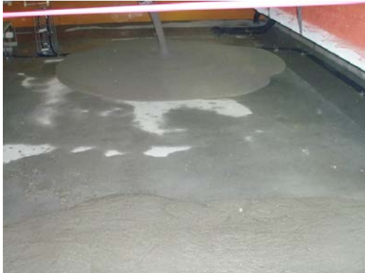
モルタル打込み打設状況
