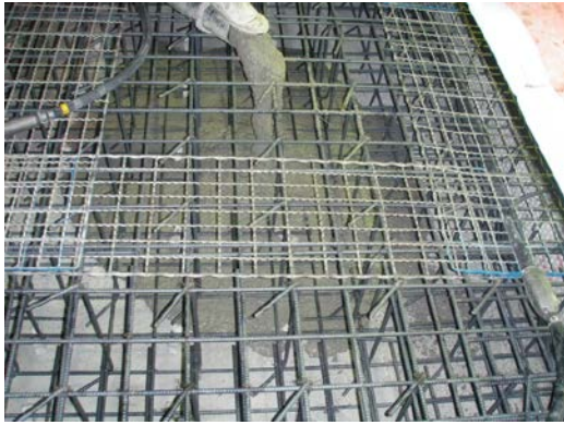
コンクリート打込み状況
