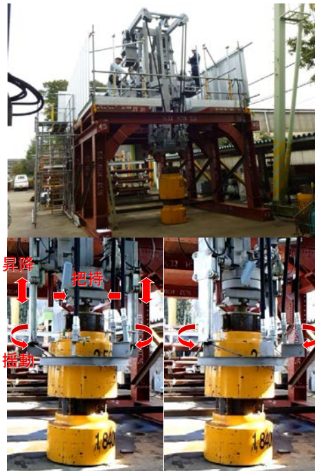
把持・振れ止めおよび昇降・揺動装置の動作確認状況
