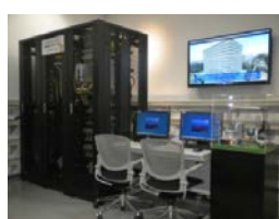
③ビル制御システム
