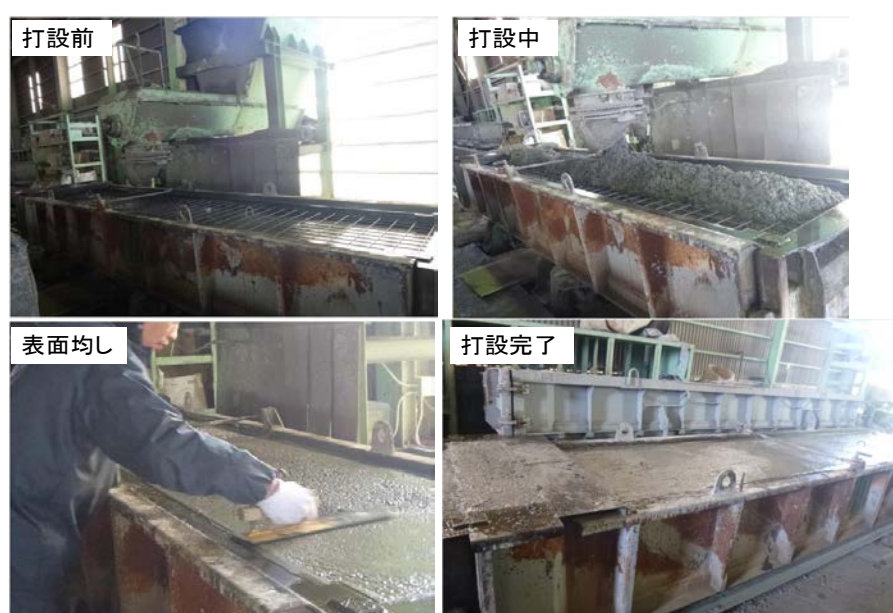
ロングベンチフリーム打設状況
