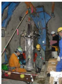
溶接部腐食試験装置の設置作業
