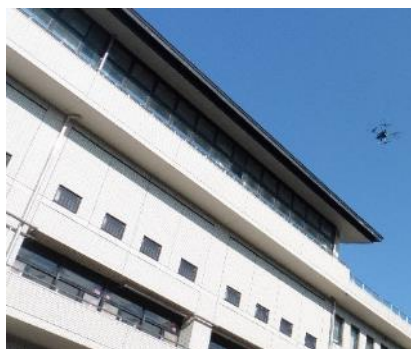
開発機による熱画像の撮影
