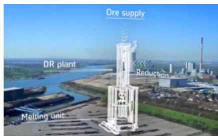
図 ThyssenKruppの直接還元炉
