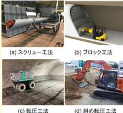
◀施工技術オプションの例
