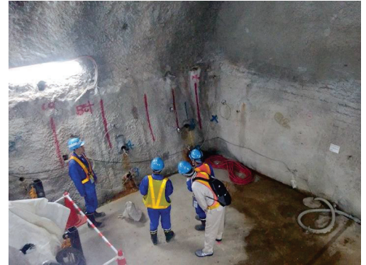
幌延国際共同プロジェクト（HIP）のタスクA（物質移行試験）における現場確認の状況（2023年9月）
