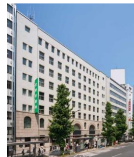
東京土地建物 本社ビル
