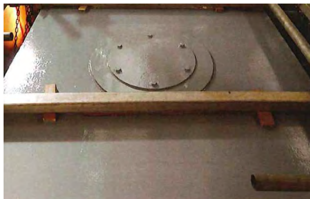
水性塗料塗布後(足場内)
