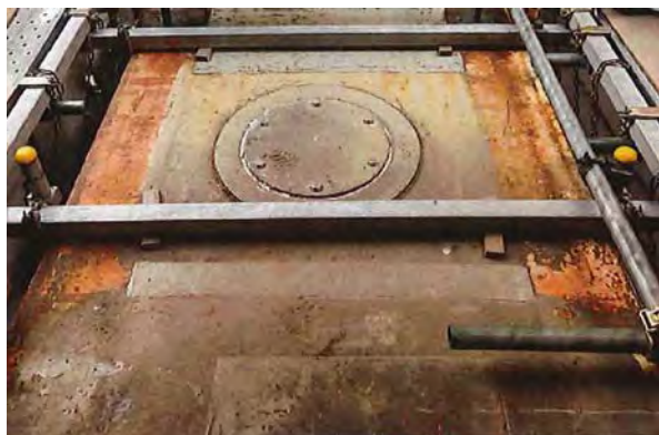
塗装前状況(足場内)
