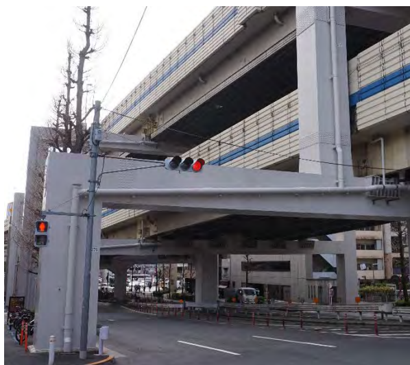
水性塗料施工後(橋脚部、全景)
