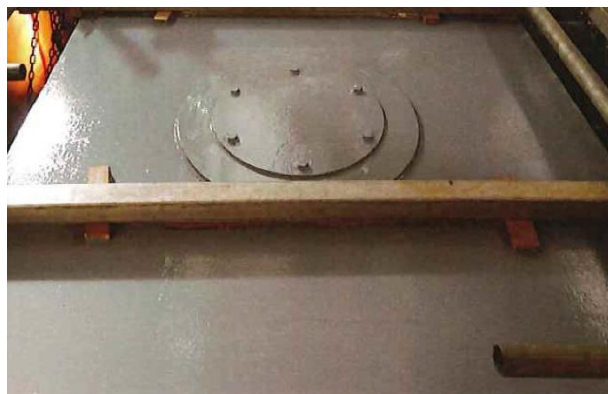
水性塗料塗布後(足場内)
