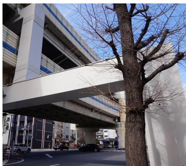
水性塗料施工後(橋脚部、全景)
