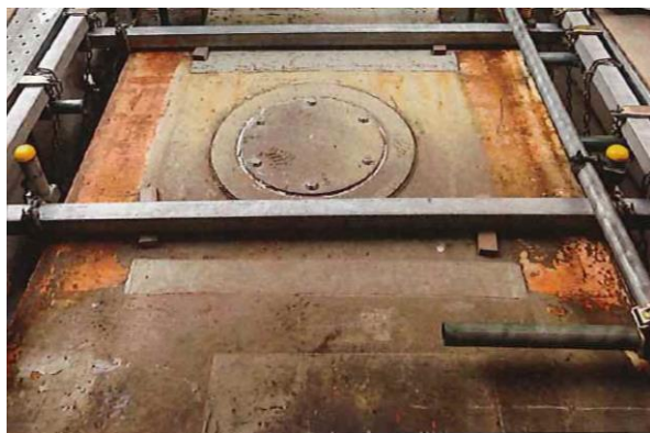
塗装前状況(足場内)
