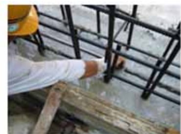
ベントナイト製品（止水材 [左]と止水材施工例 [右]）
