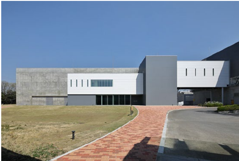
パ° イットラインを構築する産総研クリーンルーム（つくば市）
