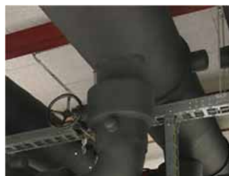
d) 冷温水・ブライン配管
