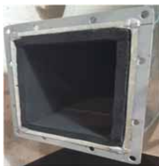
a) 屋外ダクト内張
