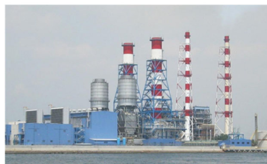
ムアラカラン発電所
