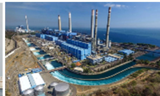
パイトン発電所
