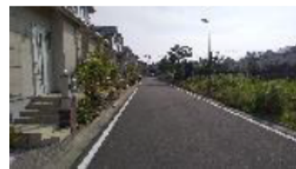
路側帯の設置された道路
