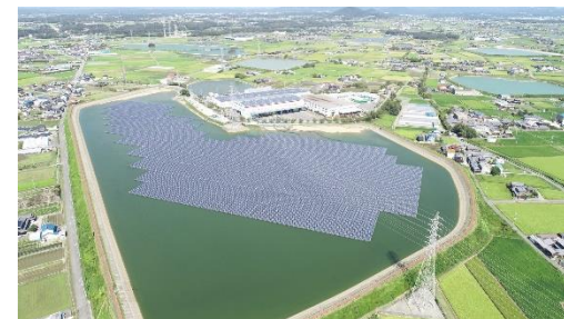
ため池を活用した水上太陽光発電
