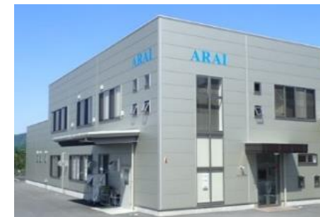
第2工場（2021年建設）
