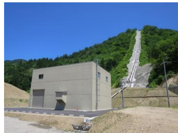
片貝別又発電所
