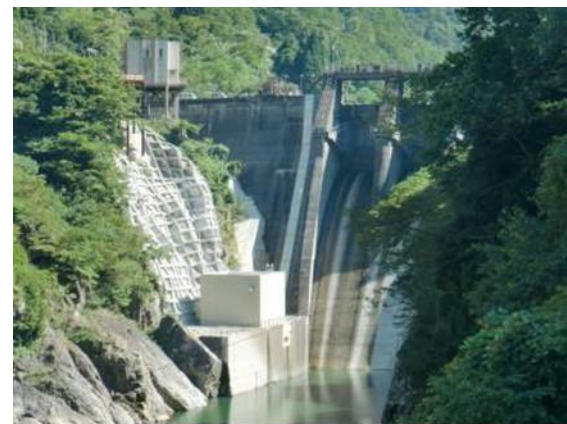
新猪谷ダム発電所
