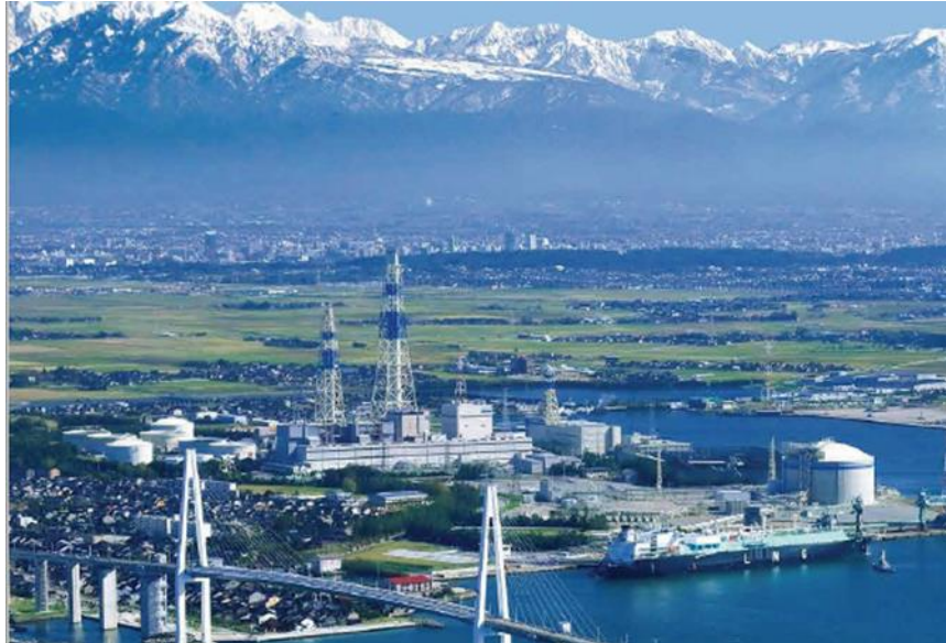
富山新港火力発電所
