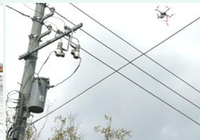
ドローンによる設備確認
