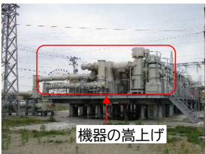
機器の嵩上げによる変電機器の冠水対策
