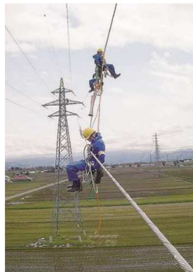
作業員が鉄塔・電線上 から目視点検
