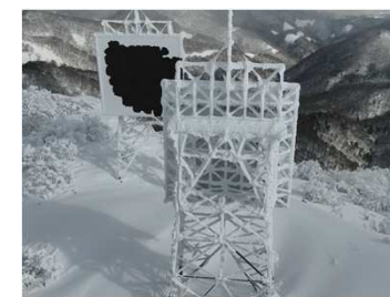
ドローンによる巡視
