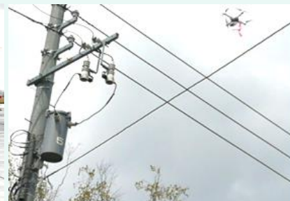
ドローンによる設備確認
