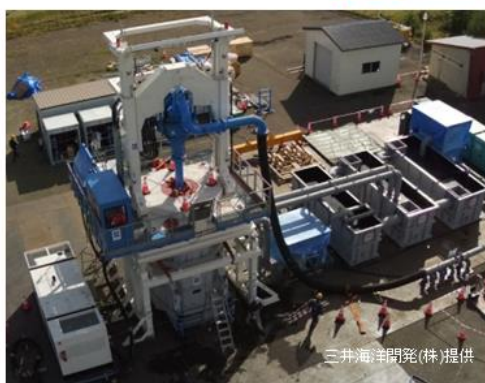
掘削試験設備全景
