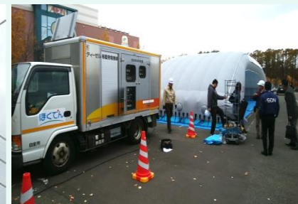
移動発電機による電力供給
