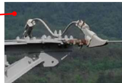
[がいし・ジャンパ装置の点検]
