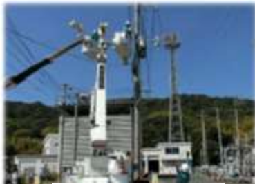
・引込線張り上げ
