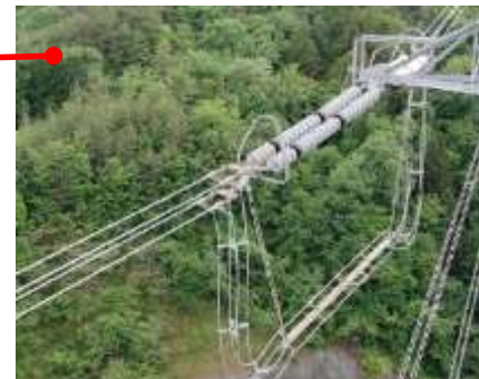
[がいし・ジャンパ装置の点検]
