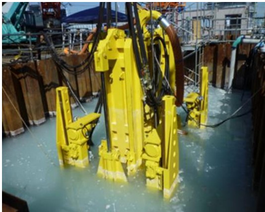
Case1 平坦面掘削の様子
