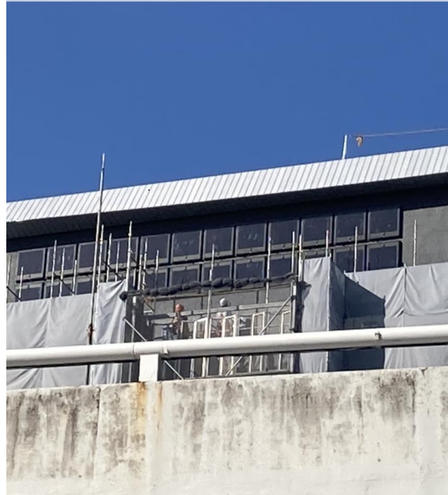
建物壁面への実装工事の様子
