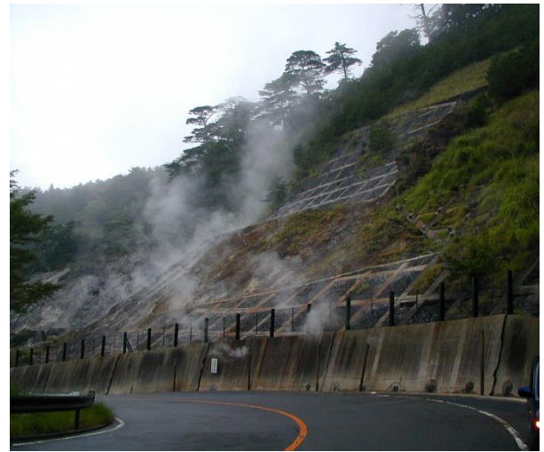
鹿児島県霧島地域の落石防止 (火山ガスによる腐食防止)
