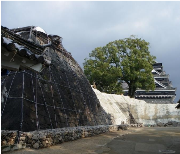
熊本地震後の熊本城復旧工事
