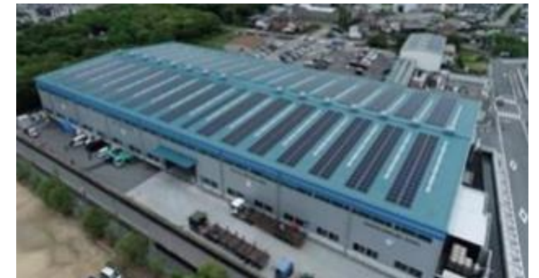
製品倉庫屋上に太陽光発電パネルを設置。製品倉庫および本社事務所の年間電力消費量を上回る約60万kWh/年の電力を太陽光発電による再生可能エネルギーで賄うことが可能。
