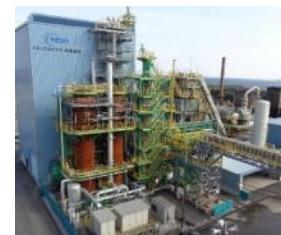
12m<sup>3</sup> 小規模試験高炉(水素還元)
