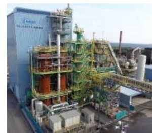
12m 3 小規模試験高炉(水素還元)
