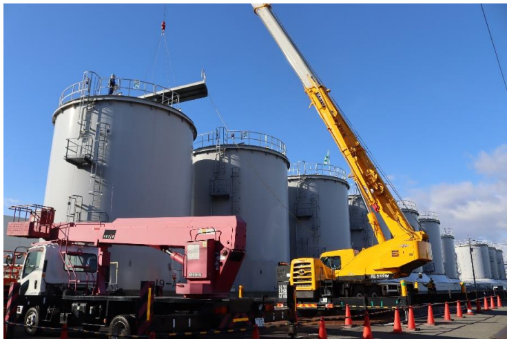
タンク上部（天蓋）を撤去する様子
