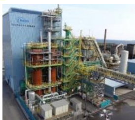
12m 3 小規模試験高炉(水素還元)
