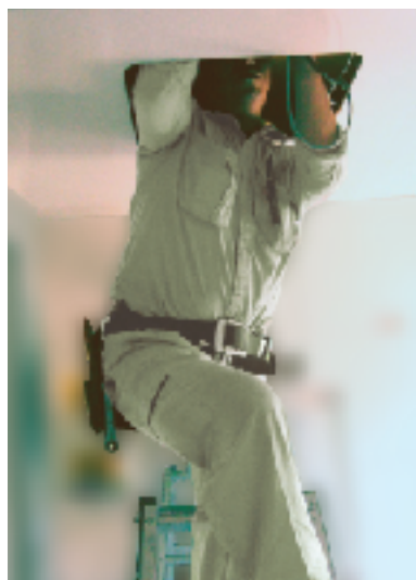
ユニットバスの点検口を開けての作業をします
