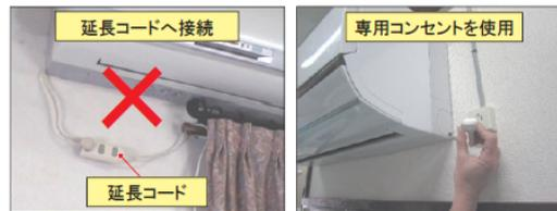
延長コード接続やタコ足配線をした場合、コードが異常過熱してしまいます。必ず エアコン専用回路のコンセント を設けて、ご使用してください。
