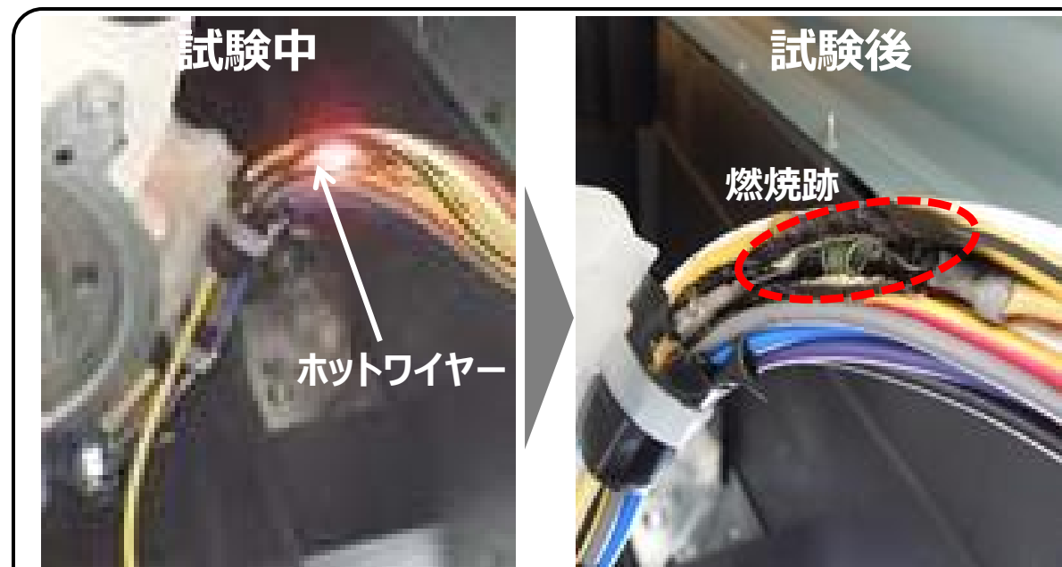
リード線結線部の燃焼確認
