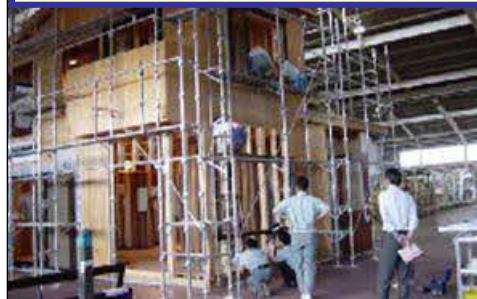
E-STAGEでの施工研修
