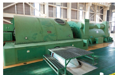
写真の「蒸気タービン」が設置された建物や冷却塔には、防音対策が施されています。約165℃、6気圧の蒸気が発電に使われます。
