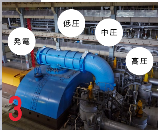
タービンに送られた蒸気の噴射力と膨張力によって、羽根車が高速回転。発電機ローターが回転し、電気をつくります。
