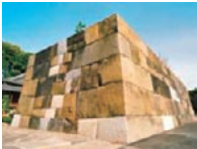
修復工事完了後（皇居東御苑内本丸中之門）
