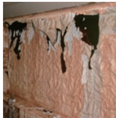
はく離剤塗布後20時間程度経過した塗膜の状態(剥がれかけている)
