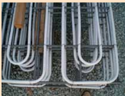
無散水融雪装置（曲げ加工部）
