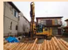
狭小地における小型重機による施工状況
