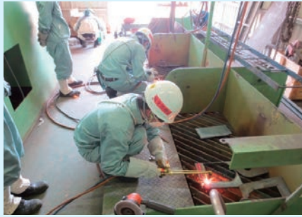
写真：ガス溶接技能講習を修了した訓練生が、ガス切断実習を行っているところ
